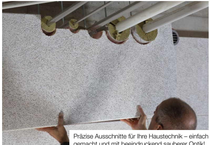
Müheloses Zuschneiden mit einer herkömmlichen Stichsäge
